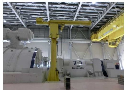
写真2 蒸気タービンと発電機
